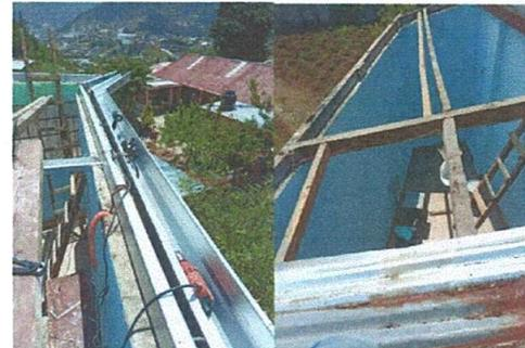
Foto 6: Colocacion de laminas troqueladas donde se filtra agua.
