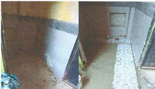
Foto 5: Foto 5: Se sustituyó la torta de cemento con la colocación de cerámica y azulejos en los tres baños y se habilitó el que no servía, como también se colocó la banqueta de los baños con cerámica.
