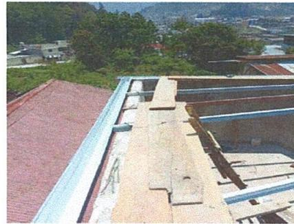
Foto 4: el cambio de techo de la Direccion y Bodega de Alimentos se procede a quitar las bigas de madera por metal.
