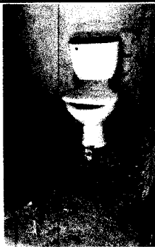
Foto 5: LA JORNADA TIENE DOS BAÑOS, UNO ESTA EN MAL ESTADO Y SE ENCUENTRA FUERA DE SERVICIO, POR LO QUE SE NECESITA HABILITARLO.
