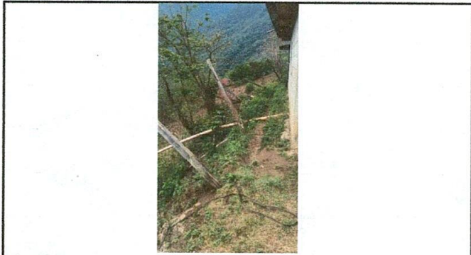
Foto1: Reparación de muro perimetral y de contencion
