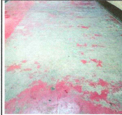
Foto 2: Sustitución de piso en la cocina
