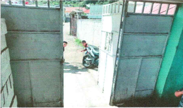
Foto1: Cambio de portón por deterioro
