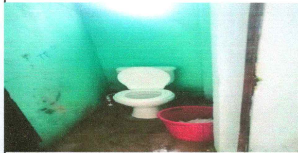
Foto 4: Mejoramiento de sanitarios con azulejo
