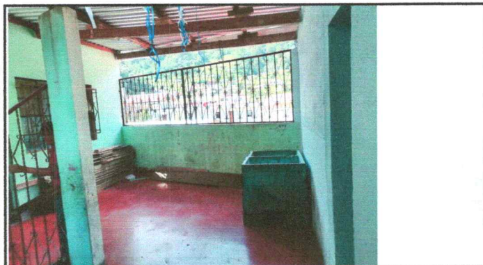
Foto 3: Colocación de la pared y ventana
