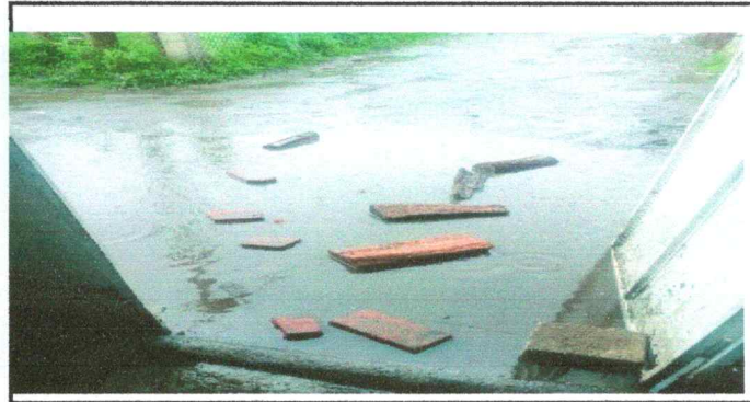
Foto 6: Salida de las aguas fluviales
