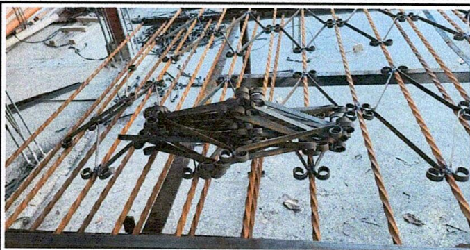
Foto 3: Fabricacion e instalación de balcones de hierro en ventanas
