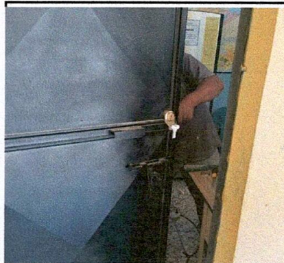
Foto 2: Sustitución de chapas
