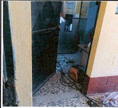
Foto1: sustitucion de chapas
