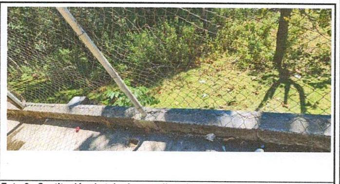
Foto 6 : Sustitución de tubo hg y malla galvanizada
