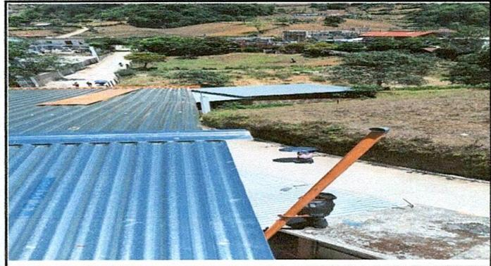
Foto 4: Sustitución de bajada de agua pluvial de metal por tubo PVC 3".
