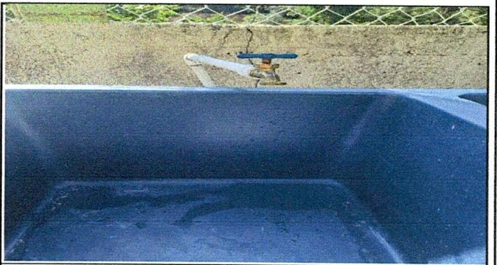
FOTO 6: SUSTITUCIÓN DE PILA.
