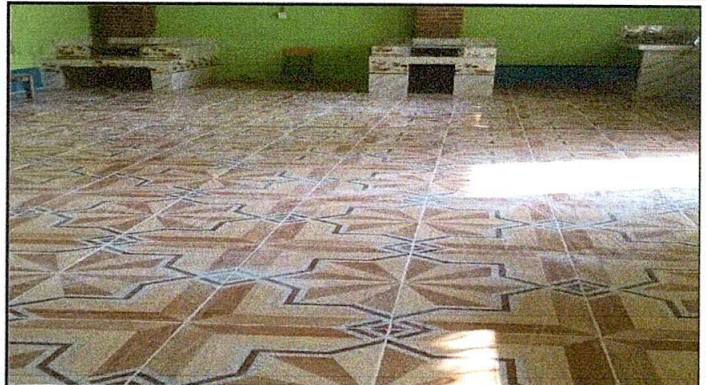
FOTO 2: SUSTITUCIÓN DE AZULEJO EN ESTUFA RURAL, SUSTITUCIÓN PARA PISO DE CERAMICA.
