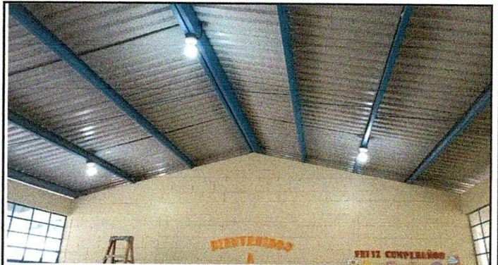
FOTO 4: INSTALACIÓN DE UNIDADES DE LUZ
