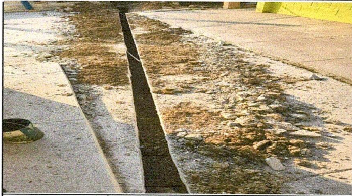
FOTO 1: REPARACIÓN DE CUNETA DE CONCRETO
