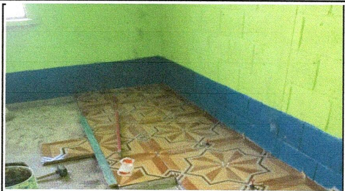
FOTO 2: SUSTITUCIÓN PARA PISO DE CERAMICA.
