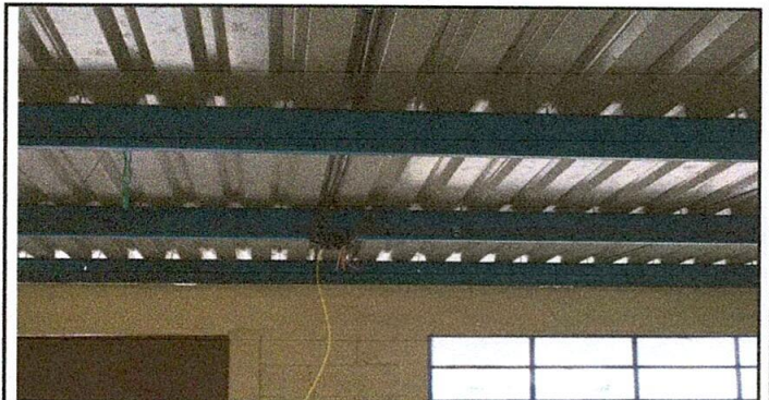
FOTO 6: SUSTITUCIÓN DE FOCOS.
