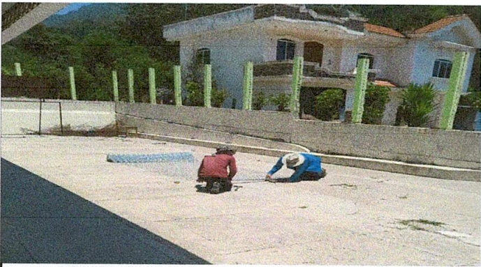
FOTO 3: REPARACIÓN DE MALLA GALVANIZADA
