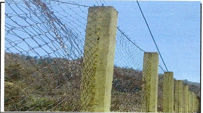
FOTO 4. SUSTITUCIÓN DE DE MALLA
