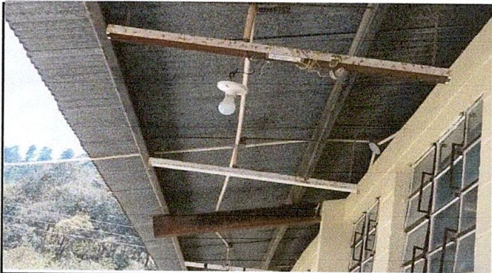
FOTO 3: MANTENIMIENTO A ESTRUCTURA DE SOPORTE DE METAL
