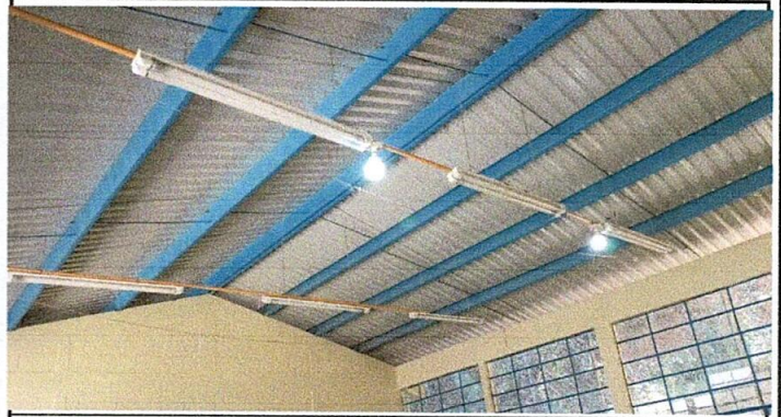
FOTO 2: SUSTITUCIÓN DE FOCOS AHORRADORES
