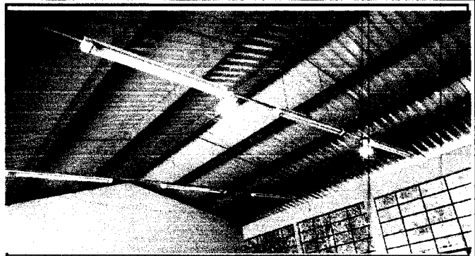
Foto. 2 Cambio y susitución de cableado.
