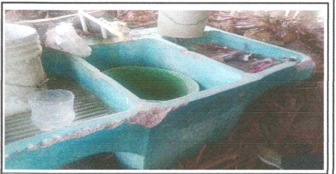
Foto 6: Pila sin valvula y quebrada
