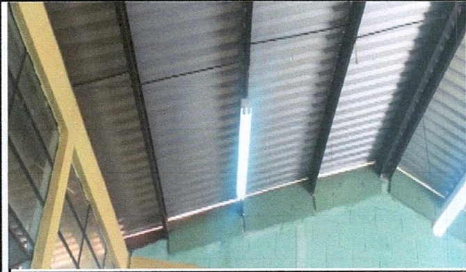
Foto 7: Sustrucción de focos
