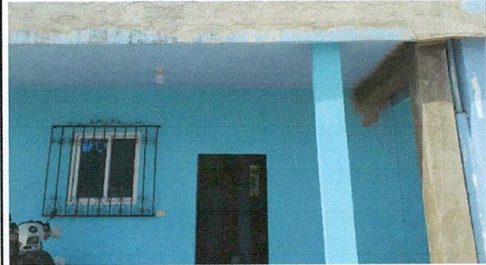
Foto 1: Sustrucción estructura de techo
