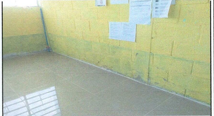
Foto 2: Sustitución de piso por cerámica
