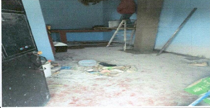
Foto1: Sustitución estructura de techo
