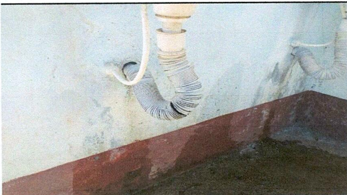
Foto 3: Sustitución de accesorios PVC de agua potable
