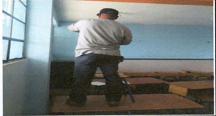
Foto 8: Sustitución de plafoneras
