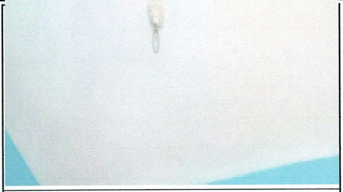
Foto 8: Sustrucción de plafoneras
