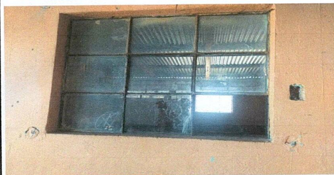
Foto 5: Colocación de valcones de hierro
