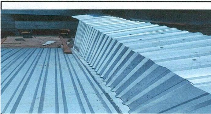
Foto 3: culminación de detalles para cubrir goteras alrededor del techo
