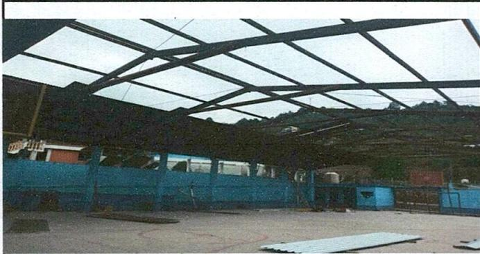
**Foto 1: Sustitucion de lámina por lámina troquelada calibre 26 en techo de la Escuela Oficial Rural Mixta, Aldea Ixtichecan, San Pedro Soloma, Huehuetenango.**
