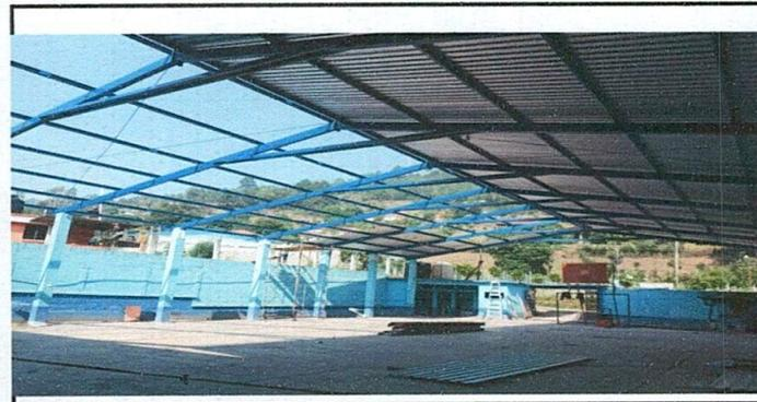
**Foto 6: colocación de lámina troquelada**
