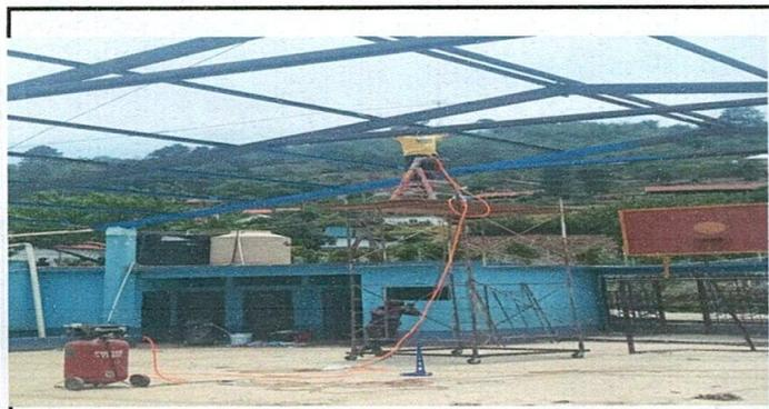
**Foto 5: Lijado de costañeras e inicio de colocación de pintura**
