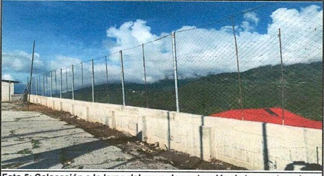
Foto 5: Colocación a lo largo del muro de contención de tres metros de maya galvanizada y tubos galvanizados.
