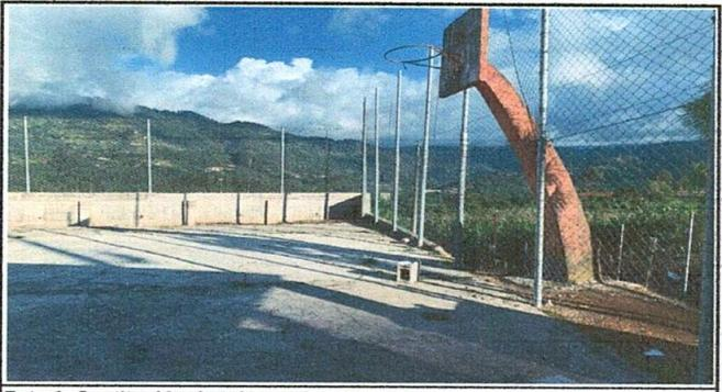
Foto 6: Sustitución de tubos galvanizados de cortos por tubos galvanizados largos con su respectiva maya también galvanizada.
