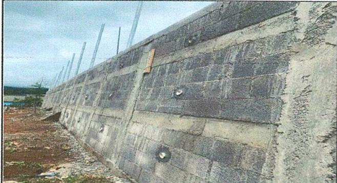
Foto 3: Sustitución total del muro de contención de dos metros setenta y cinco centímetros de altura y dos metros de arranque (profundidad)
