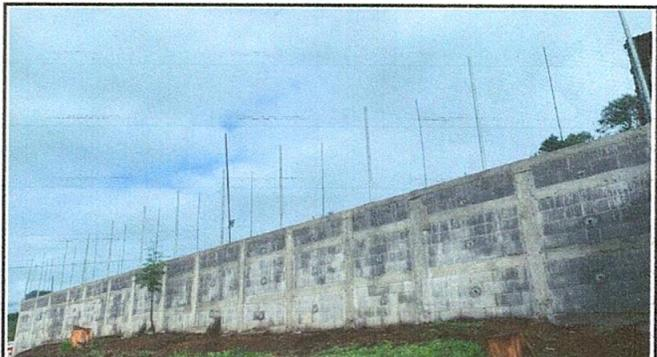
Foto 4: Muro de contención de 27 a 29 metros de longitud
