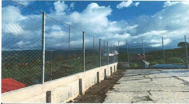
Foto 1: Relleno con tierra a lo largo de todo el muro de contención
