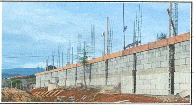
Foto 6: Colocación de la segunda solera en el muro para una mayor seguridad del proyecto que se esta ejecutando.
