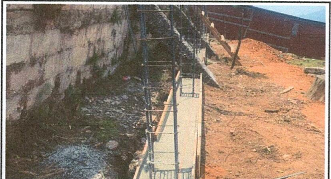
Foto 3: Fundición de la base del muro
