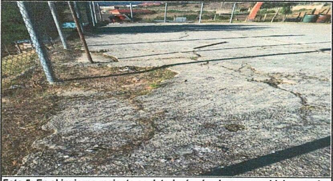
Foto 5: En el invierno reciente se deterioró más el muro y se hicieron más notorias las rajaduras del concreto de la cancha deportiva
