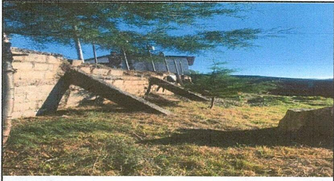
Foto 3: Eliminación de varios árboles que interfieren el el levantadode nuestro muro
