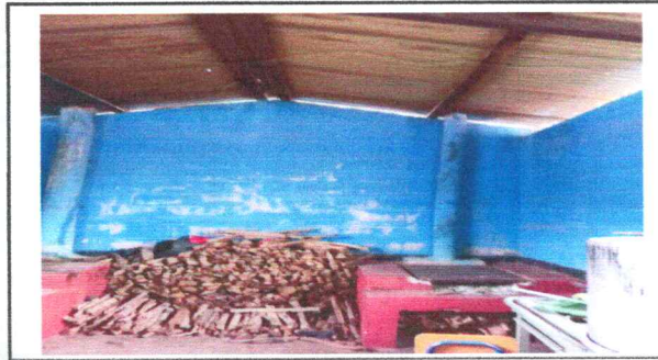
Foto 4: Cambio de costanera de madera por metal
