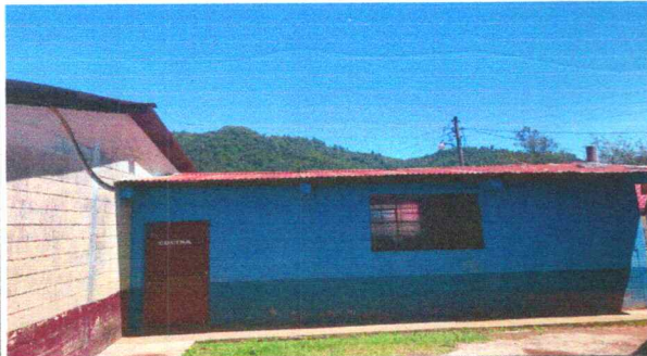
Foto 3: Cambio de lamina de cocina por estructura de metal
