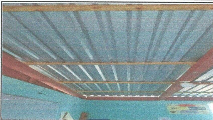
Foto 2: Techo culminado en las aulas
