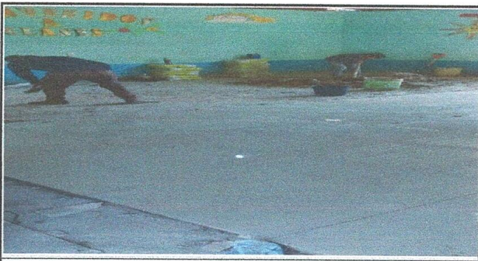
Foto 6: Colocación del piso cerámico.
