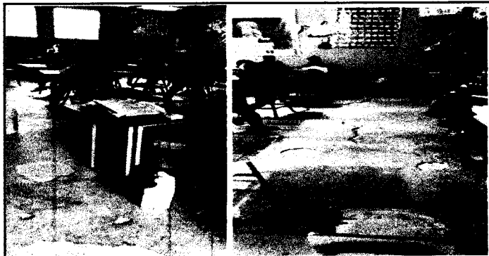
Foto 5: Piso agrietado
