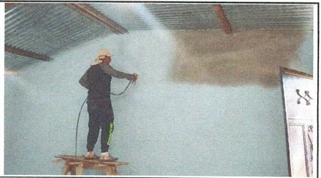
APLICACIÓN DE PINTURA A MUROS Y PUERTAS
