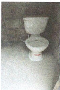
INSTALACION DE 6 TASAS DE BAÑO POR LETRINAS Y REPELLO DE MUROS
