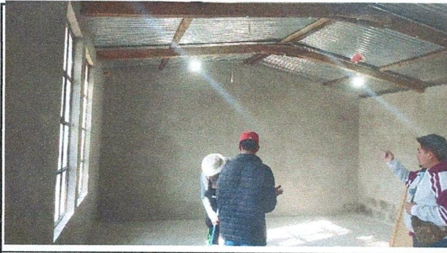
REPELLO DE 2 SALONES Y ALISADO DE PISO
