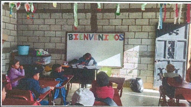
2 Aulas de 8X6 metros sin repello y funcionamiento de energía eléctrica
