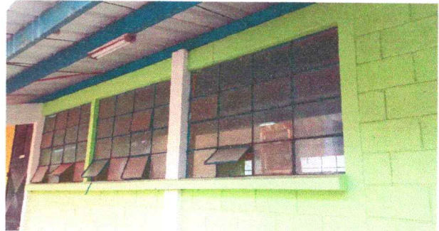
Foto 4: Mejoramiento balcones en laboratorio de computación
