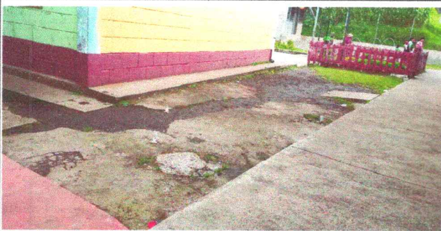
Foto 5: Reparación piso patio
