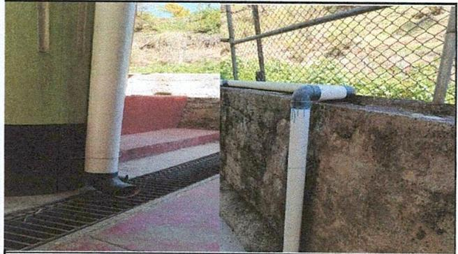
Foto 4: Reparación de bajda de agua pluvial, tubo pcv.
