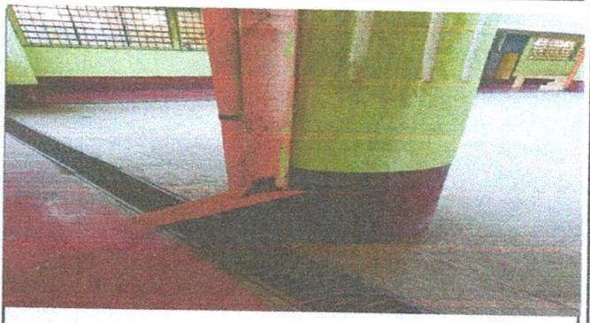
Foto 4: Reparación de bajada de agua pluvial, tubo pvc
