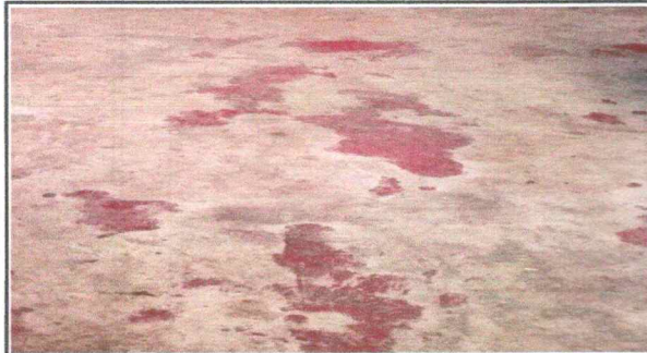
Foto 7: SUSTITUCIÓN DE PISO DE TORTA DE CONCRETO POR PORCELANATO AULA 1
