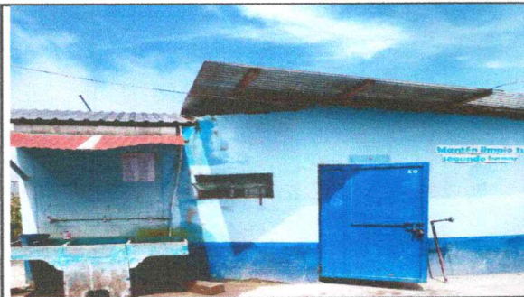
Foto 3: SUSTITUCIÓN DE VENTANA
