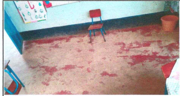
Foto 8: SUSTITUCIÓN DE PISO DE TORTA DE CONCRETO POR PORCELANATO AULA 2
