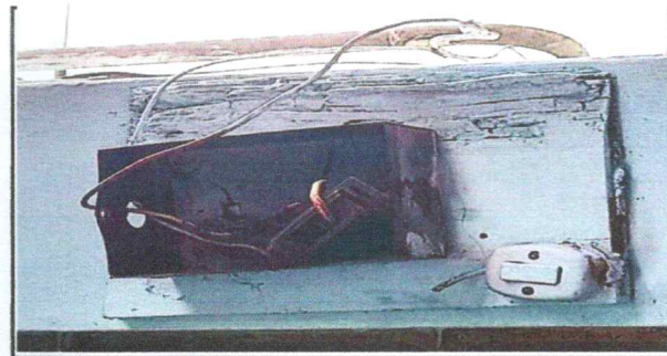
Foto 11: FLIPONES DETERIORADOS
