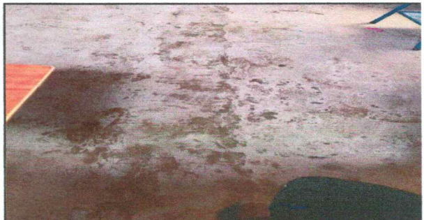
Foto 6: REPARACIÓN DE PISO DE TORTA DE CONCRETO
