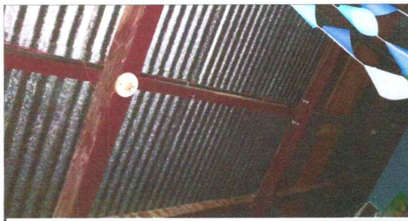
Foto 11: REPARACIÓN DE SISTEMA ELECTRICO
