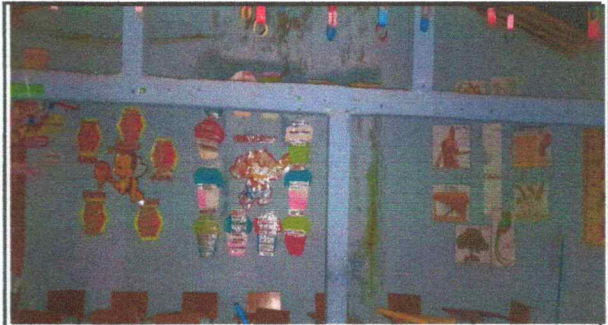
Foto 2: MEJORAMIENTO DE PARED CERNIDO Y REPELLO
