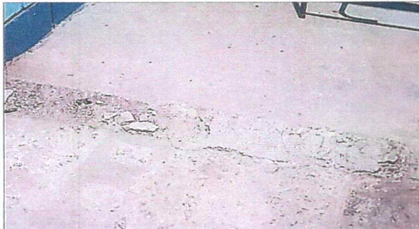
Foto 9: SUSTITUCIÓN DE PISO DE TORTA DE CONCRETO POR PORCELANATO AULA 3
