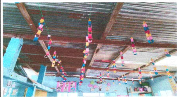
Foto1: CAMBIO DE CUBIERTA DE LAMINA
