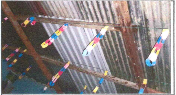
Foto 4: SUSTITUCIÓN DE ESTRUCTURA MADERA POR METAL
