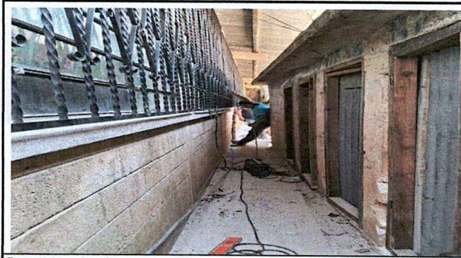
Foto 3: instalación de balcones
