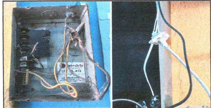
Foto 6: Daño en sistema electrico en general por corto circuito
