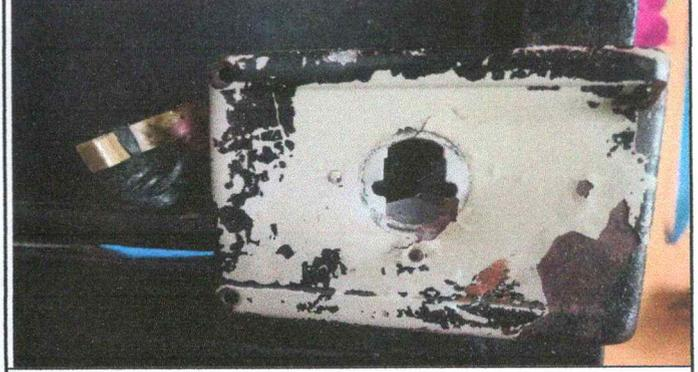
Foto 2: Chapas de puertas de aulas deterioradas
