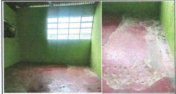
Foto 4: Piso de cocina en mal estado es necesario sustituirla por piso de granito
