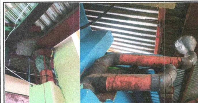
Foto 5: Daño en canales y bajadas de agua
