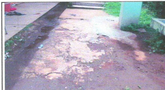
Foto 3: Planchas de concreto de patio dañados
