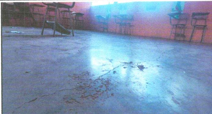
Foto 1: Piso de torta de concreto obsoleto
