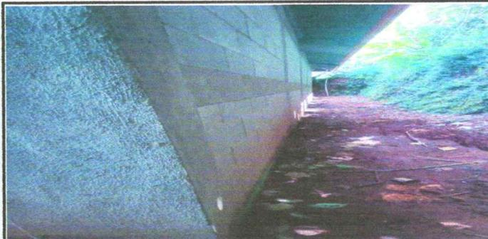
Foto 2: Penetración de humedad en espacios no repellados
