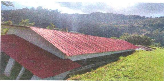
Foto 5: Sustitución de la minas por troqueladas
