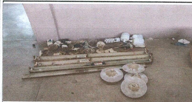
Foto 5: terminando de quitar todos los materiales en desuso
