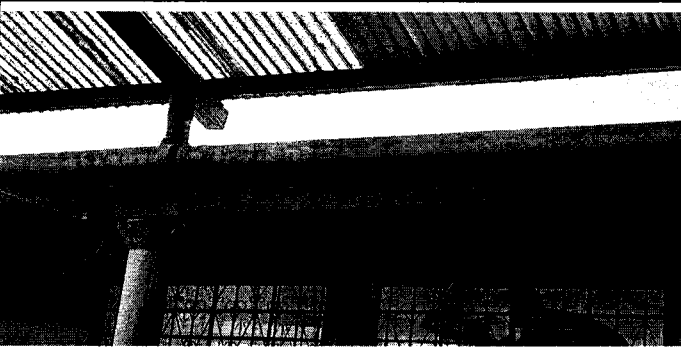
Foto 5: daño en canales y bajadas
