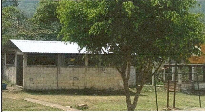
Foto1: techo de lamina troquelada nueva instalada
