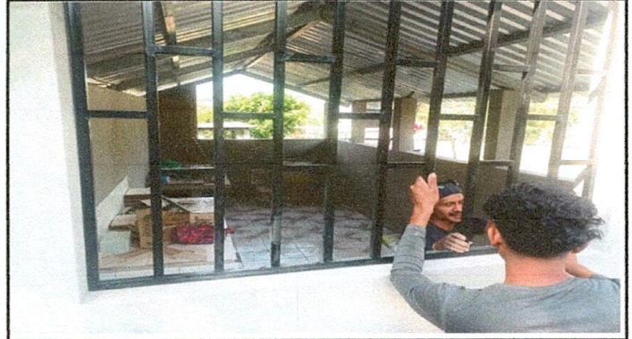
Foto 2: ventana balcon nueva instalada
