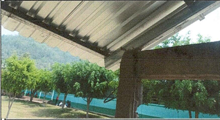
Foto1: estructura portante de metal para techo finalizado
