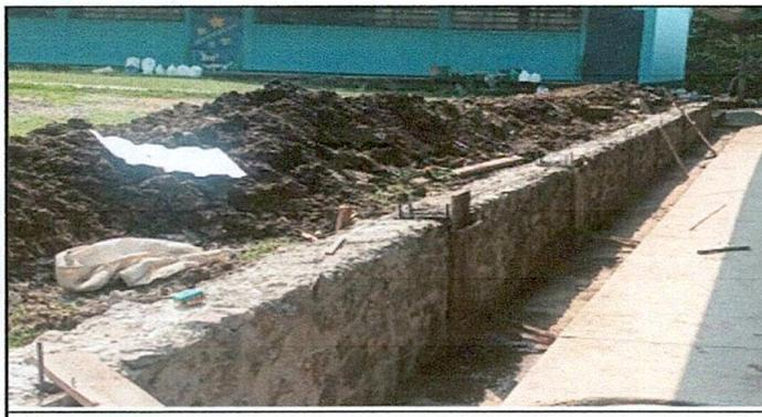
Foto 5: fundicion de columnas para reforzamiento del muro de contension
