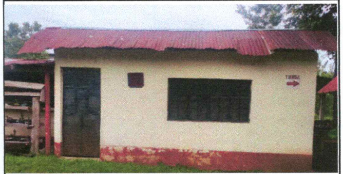
Foto 2:Sustitución techo de bodega
