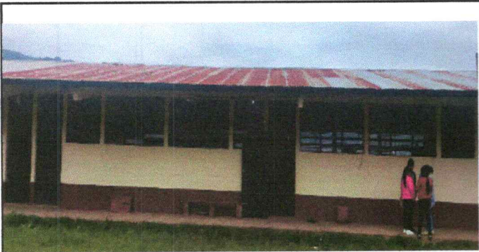
Foto1: Sustitución de techo de aulas
