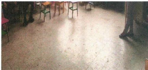
Foto 5: piso de granito en mal estado
