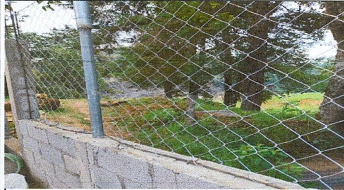
Foto1: Remozamiento de circulación del predio escolar
