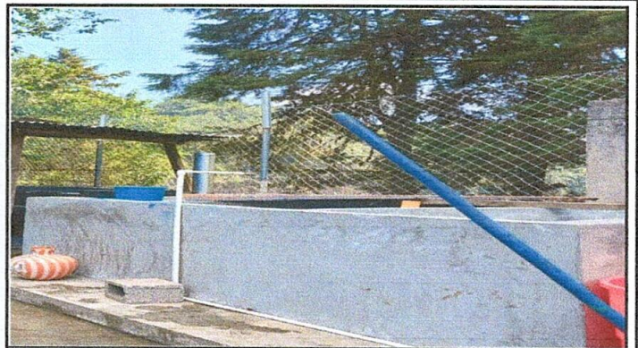
Foto 8: Sustitución de pila para cocina
