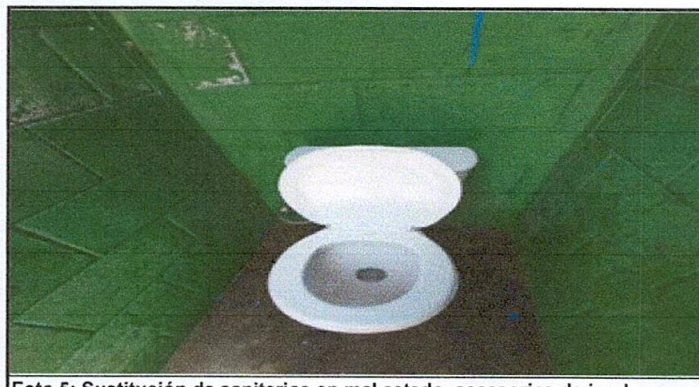
Foto 5: Sustitución de sanitarios en mal estado, accesorios de inodoro y tapadera sanitaria
