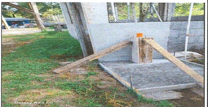
Foto 6: Sustitución de lavamanos
