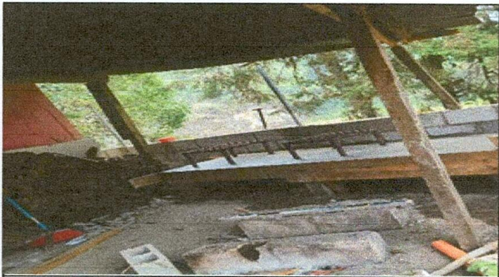
Foto 9: Mejoramiento y mantenimiento de estufa rural (fogones)
