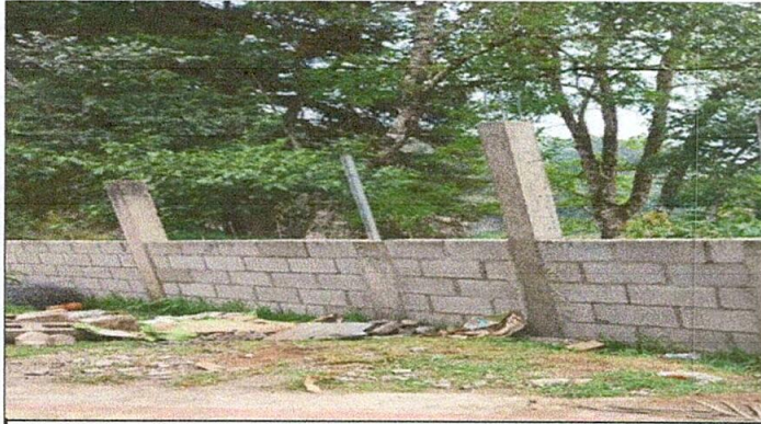
Foto 1: Remozamiento de circulación del predio escolar
