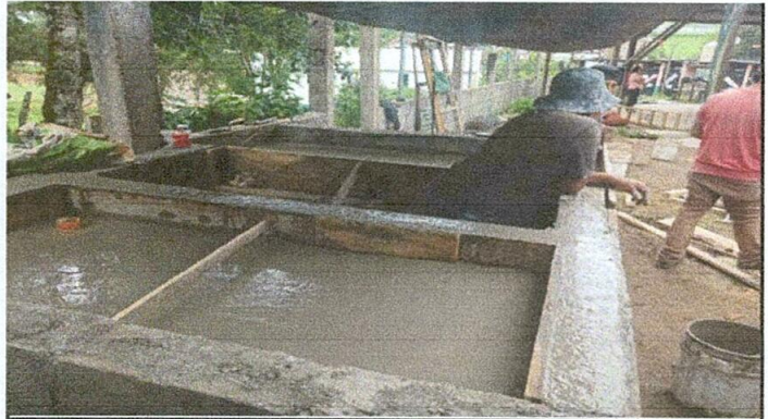
Foto 8: Sustitución de pila para cocina
