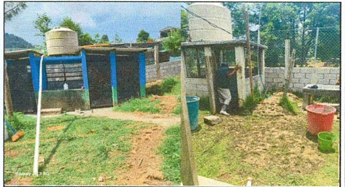
Foto 2: Reparación de red de drenaje y agua potable
