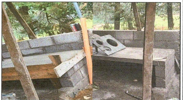
Foto 4: Sustitución y mejoramiento de plancha en mal estado
