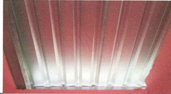
Foto 2: Lámina troquelada calibre 26 en baños.
