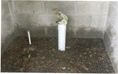
Foto 7: Sustrucción de línea principal de drenaje tubo PVC.
