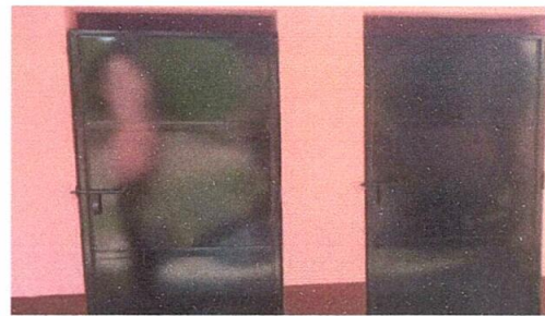
Foto 6: Sustitución de puertas en baños.
