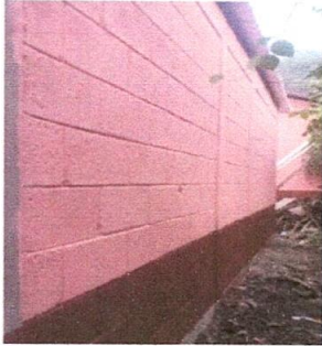
Foto1: Mejoramiento de muro en baños.
