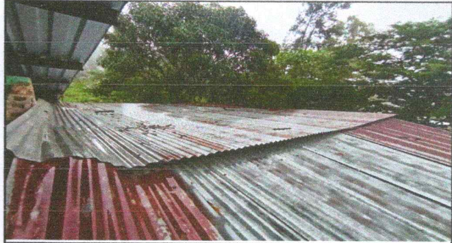
Foto 2: CUBIERTA DE LAMINA
