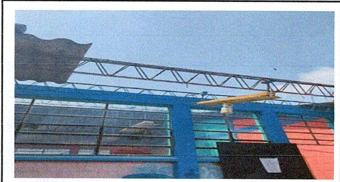
Foto 1: Sustitucion de laminas troqueladas aluzinc
