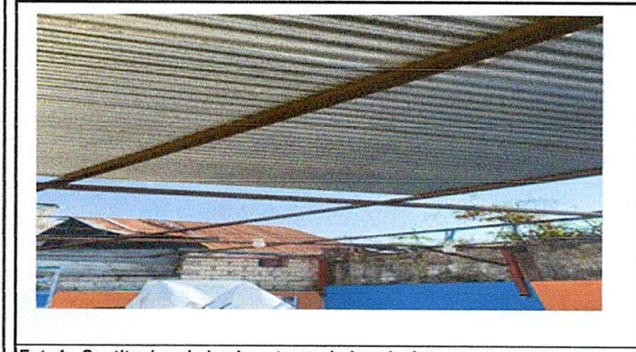
Foto1: Sustitucion de laminas troqueladas aluzinc
