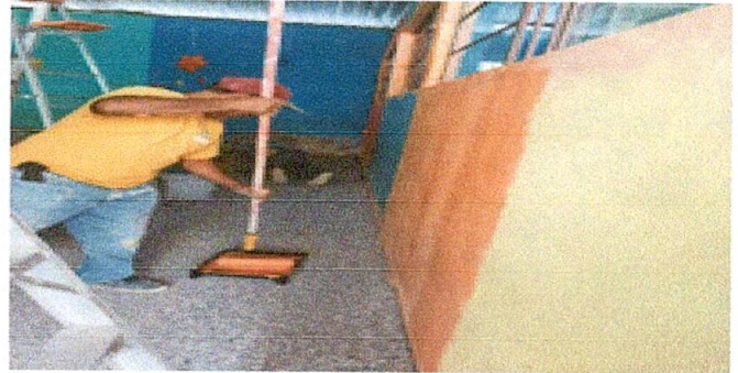
Foto 4: Pintado interior y exterior
