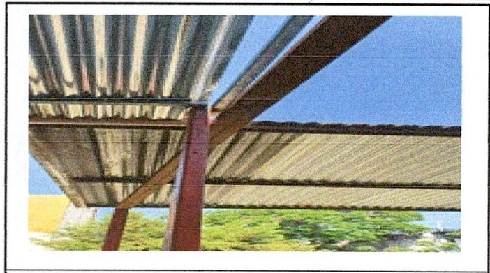
Foto 2: Sustitucion de laminas troqueladas aluzinc
