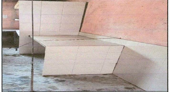
Foto 2: Trabajo de mesas y azulecos culminados en la cocina y sustitución de mueble de madera por concreto.
