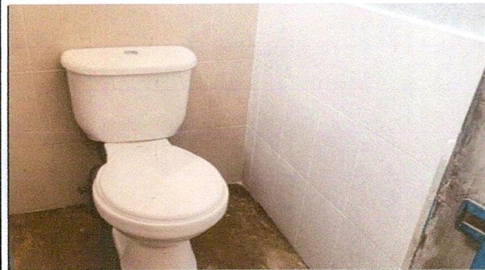
Foto 3: Inodoros instalados en los baños
