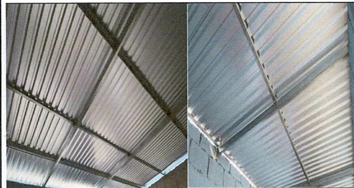
Foto 5: Techo culminadas de las dos aulas, láminas y costaneras puestas
