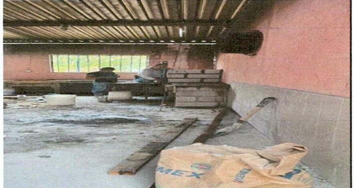
Foto 2: sustitución de muebles por muebles de cemento
