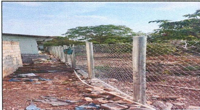
Foto1. Reparación de muro perimetral con block
