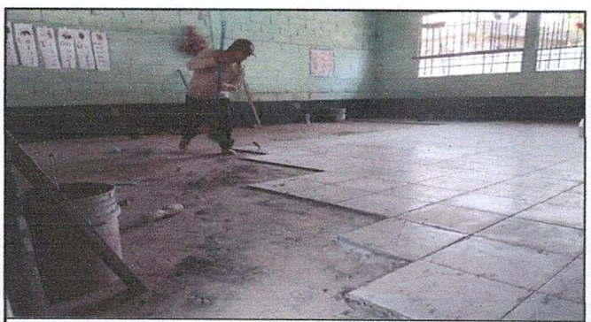
Foto 6. Sustitución de torta de cemento por piso cerámico
