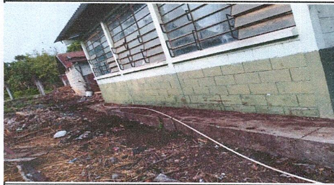
Foto 1. Reparación de muro perimetral con block
