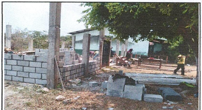
Foto 4. Mejoramiento de paredes de cocina
