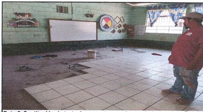
Foto 5. Sustitución de torta de cemento por piso cerámico
