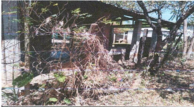
Foto 1. Estado actual de la circulación de la cocina.
